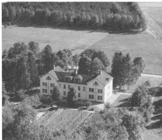
Flygfoto över gamla ålderdomshemmet i Sannahed taget innan ännu tätorten börjat växa upp på heden. Det var från början huvudbyggnad på Sannaheds mötesplats inrymmande kanslilokaler och officersbostäder och blir nu Centrumhuset med bibliotek och samlingslokaler.
